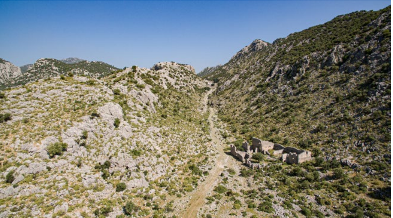
Döşemeboğazı – Via Sebaste yolu genel görünüm
